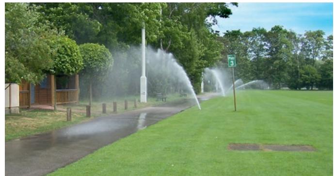
Abb. 27: Falsch bzw. ungenau eingestellte Regner
