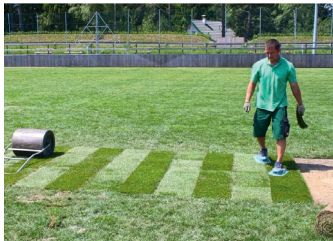
Abb. 24: Verlegen von Rollrasen im Torraum
