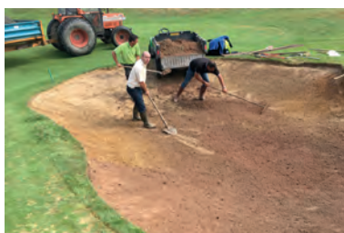
Préparation du bunker
