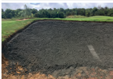
Mise en œuvre de Cleanbunk® sur une couche uniforme de 7-9 cm d'épaisseur
