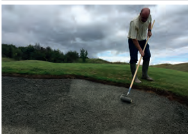
Mise en œuvre de Cleanbunk® sur une couche uniforme de 7-9 cm d'épaisseur
