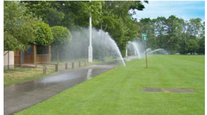
Abb. 27: Falsch bzw. ungenau eingestellte Regner
