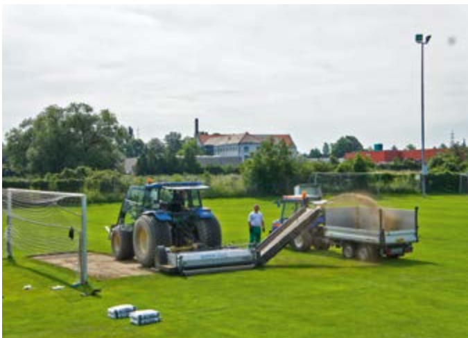
Abb. 23: Abfräsen abgenutzter Spielbereiche
