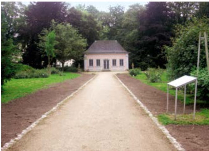
Abb. 29: Vorbereitung von Pflanzbeeten, die dann als Betonung der Wegführung und Sichtachse zum Pavillon dienen
